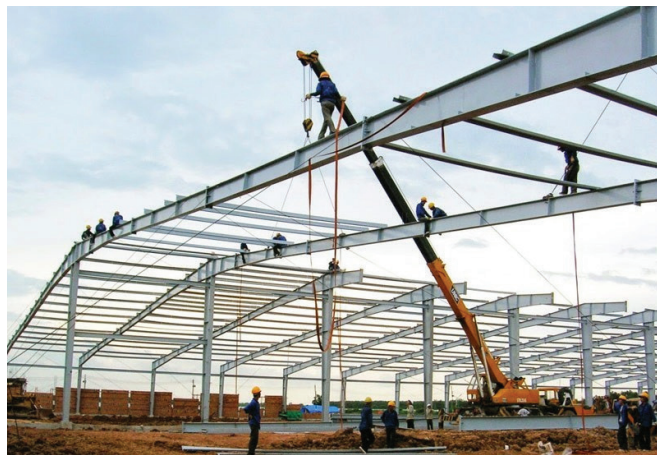
02 Thi công nhà xưởng công nghiệp tại TP. Hồ Chí Minh
