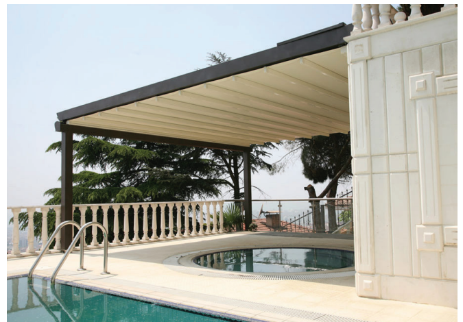
12 Thi công mái che hồ bơi tại TP. Hồ Chí Minh
