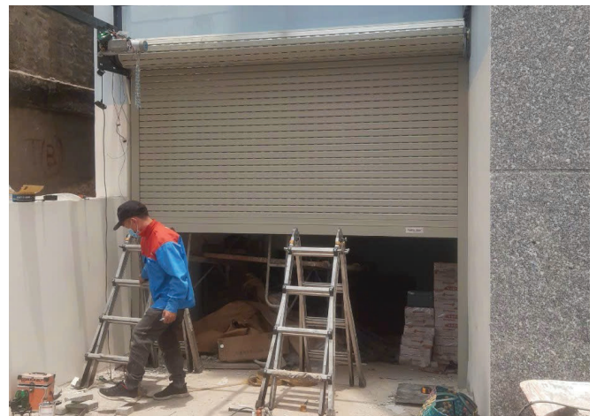
10 Thi công cửa cuốn nhà phố tại TP. Hồ Chí Minh
