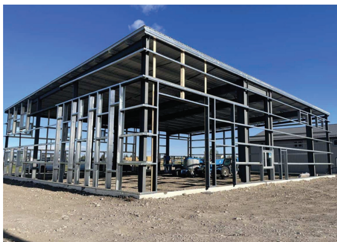
03 Dự án thi công nhà xưởng tiền chế công ty dệt may
