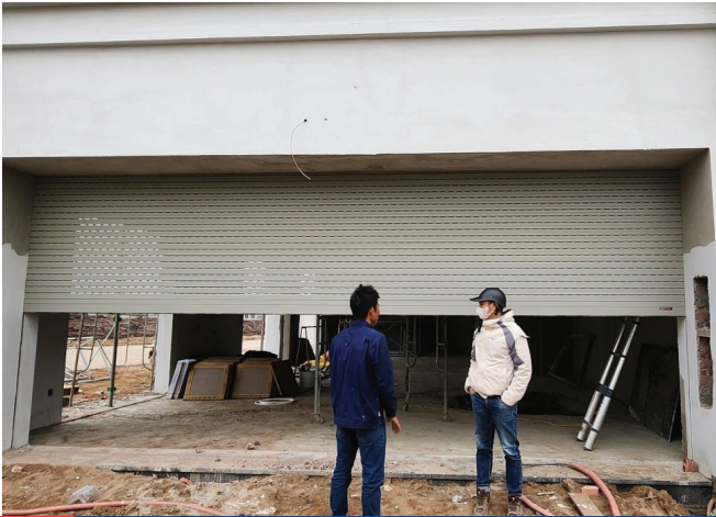
07 Thi công cửa cuốn kho hàng tại TP. Hồ Chí Minh
