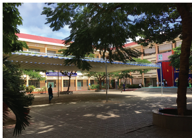
06 Thi công mái che sân trường tại TP. Hồ Chí Minh
