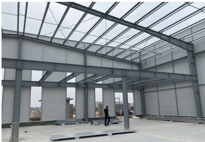
01 Thi công nhà tiền chế cho xưởng cơ khí anh Hoàng
